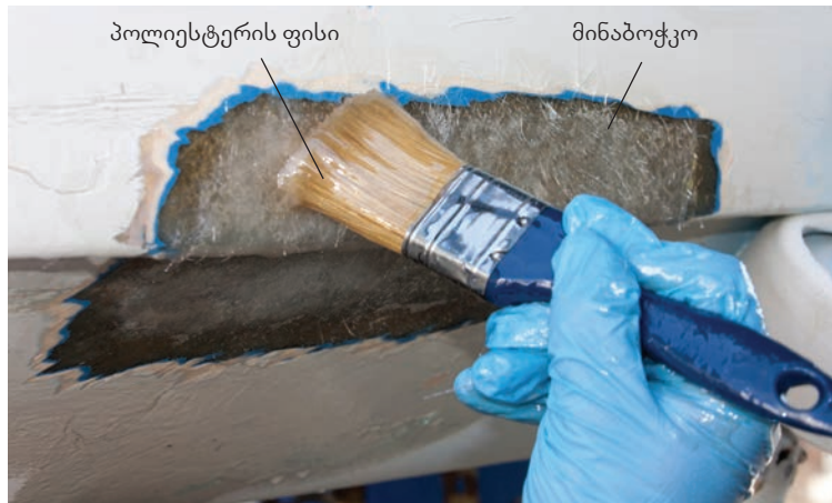
B | მინარმირებული პლასტმასა არის კომპოზიტი – მინაბოჭკოვანი პოლიესტერის ფისი. ის გამოიყენება ნაგებობის მშენებლობასა და რემონტში, რადგან არის მტკიცე, მსუბუქი და ოდნავ დრეკადი. მინაბოჭკო ადვილად იღებს სხვადასხვა ფორმას, რომლებიც მყარდება ფისთან ერთად.
